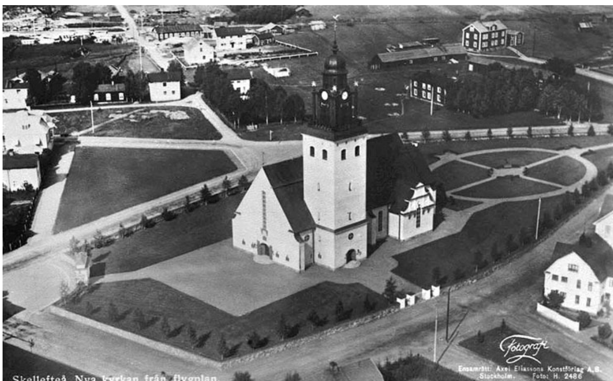
Skellefteå. Nya kyrkan från flygplan. Bild C 00816 Flygfoto över Skellefteå stadskyrka, St Olofs.
