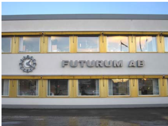
Kontorets horisontella fönsterband hålls samman med guldeloxerade aluminiumplåtar.
