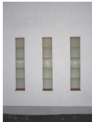
Gavlarnas vertikala fönsterform ger kontrast till den i övrigt horisontella linjeföringen i exteriören.
