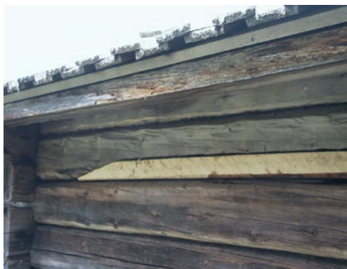
Bild 5. Skarvning av stock på östra fasaden.
