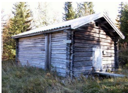
Bild 2. Torkbastun före åtgärd.
