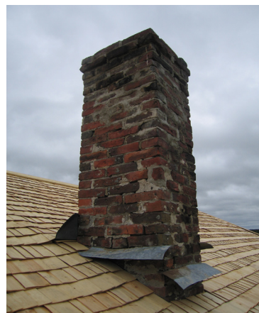
Bild 9. Södra skorstenen efter åtgärd.
