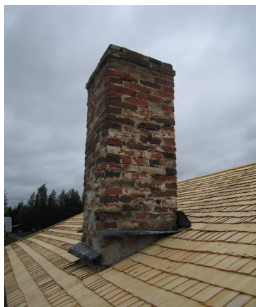
Bild 8. Norra skorstenen efter åtgärd.
