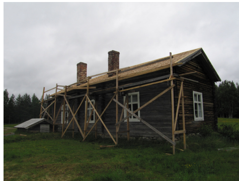
Bild 7. Nordvästra takfallet efter åtgärd.
