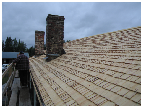
Bild 6. Nylagt spån på nordvästra takfallet.
