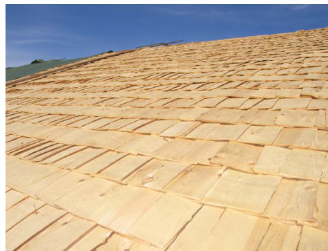
Bild 5. Nylagt spån på sydöstra takfallet.
