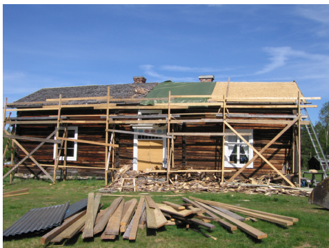
Bild 4. Sydöstra takfallet under åtgärd.
