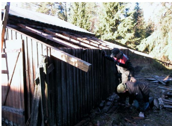
Bild 2. Fårhuset efter rivning av befintligt tak påbörjats.
