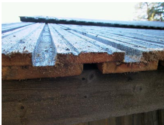
Bild 3. Närbild av taket efter åtgärd.
