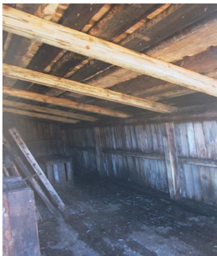
Bild 5. Fårhuset invändigt efter åtgärd.
