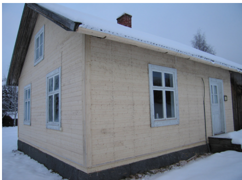
Bild 4. Drängstugan efter åtgärd.
