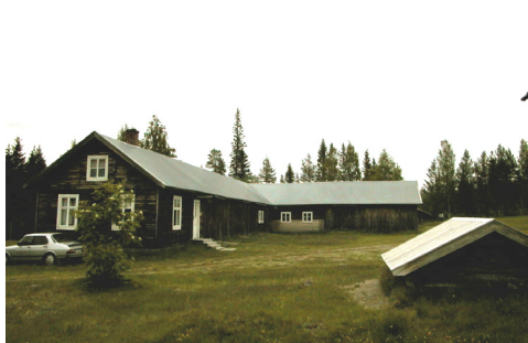
Bild 2. Drängstugan före åtgärd.
