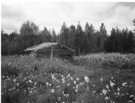
Bild 20. Nödårsladan före åtgärd.
