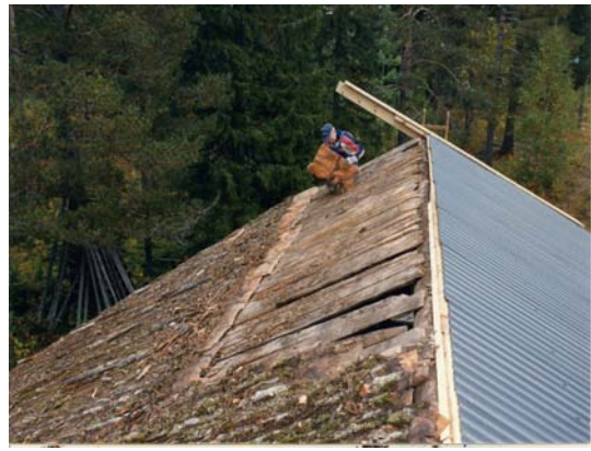
Bild 33. Borttagning av gammal taktäckning.
