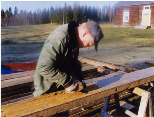
Bild 55. Färg skrapas bort från enkelstugans köksgolv. Bild 56. Nödärsladans nävertak under åtgärd.
