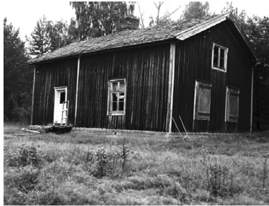
Bild 25. Ödehuset i Östra Stenbäcken före åtgärd.
