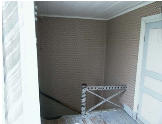
Bild 60. Övre delen av trappan efter tapetsering.
