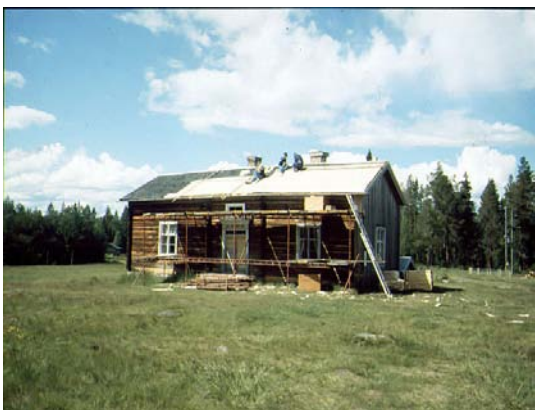
Bild 28. Omläggning av spåntaket på parstugan.
