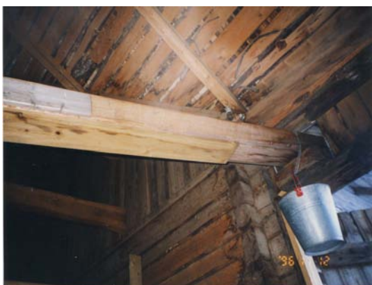
Bild 52. Hängrännan genom stallporten efter åtgärd.
