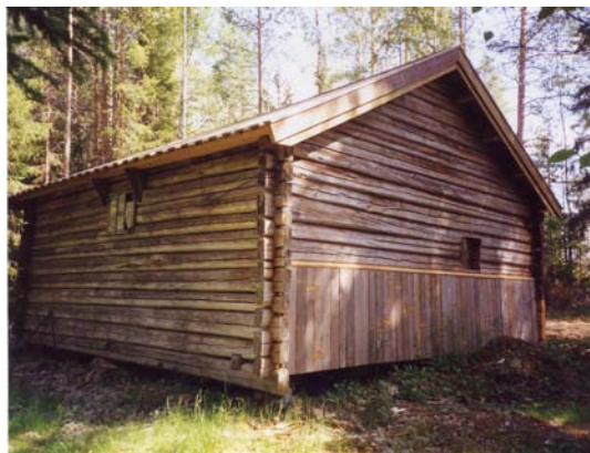
Bild 40. Inbrädning av baksidan.
