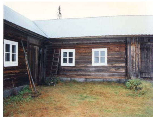
Bild 14. Fähusets exteriör före åtgärd.
