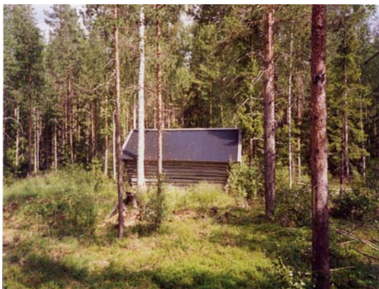
Bild 26. Lada efter åtgärd.
