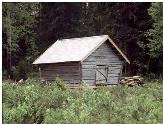
Bild 27. Lada bakom bagarstugan efter åtgärd.
