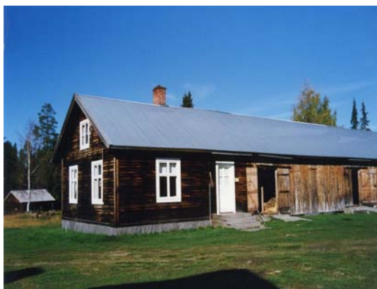
Bild 38. Drängstugan efter ommålning av fönster och dörr.
