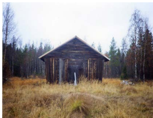
Bild 44. Södra ladan efter åtgärd.
