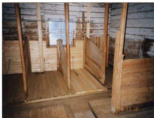
Bild 50. Kobåsen efter åtgärd av golv och ränna.
