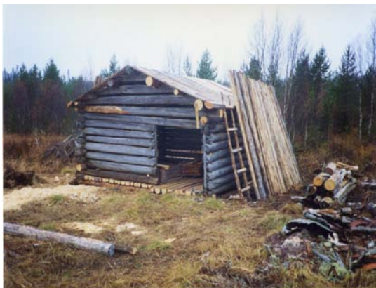
Bild 45. Nödårsladan efter åtgärd av stomme.
