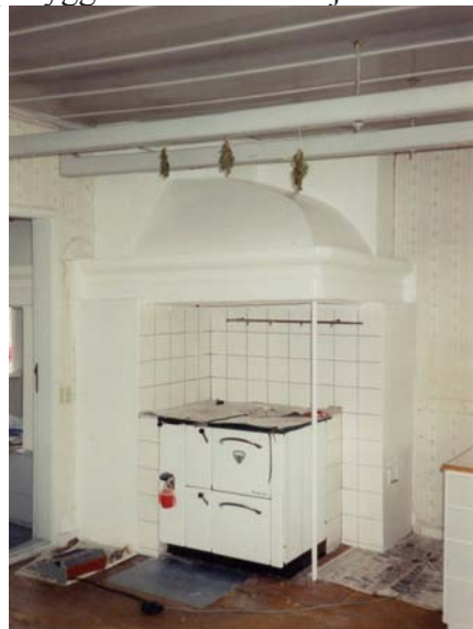
Bild 42. Spiskåpan i köket efter åtgärd.
