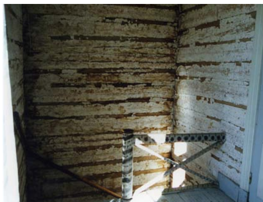
Bild 4. Trapphallen uppe före åtgärd.
