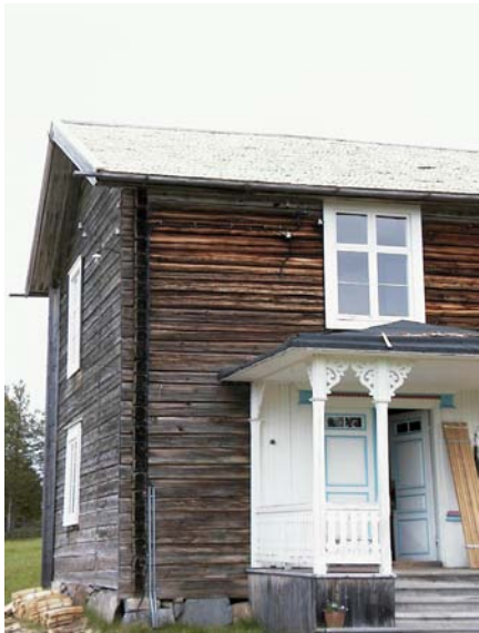
Bild 57. Enkelstugan efter byte av spåntak.
