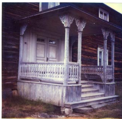
Bild 3. Farstubron före åtgärd.
