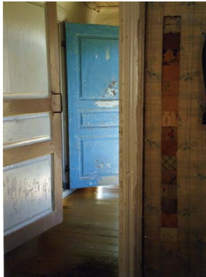
Bild 54. Tapetrappa i parstugans kök efter omtapetsering.
