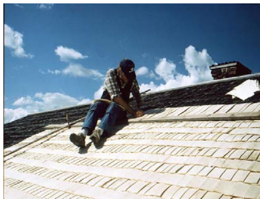
Bild 29. Omläggning av parstugans spåntak.
