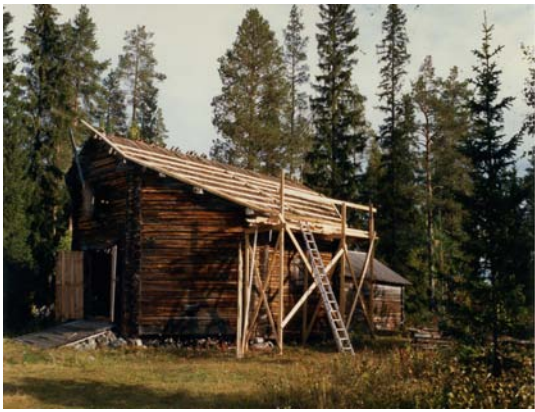
Bild 32. Rundlogens tak under åtgärd.
