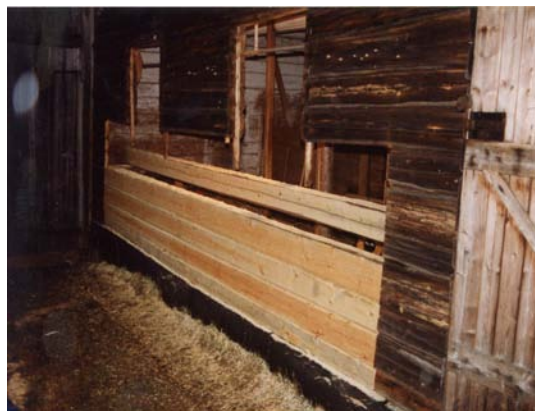
Bild 48. Återuppbyggnad av timmerväggen.
