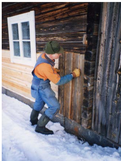
Bild 51. Inpanelning av ladugårdsväggen.
