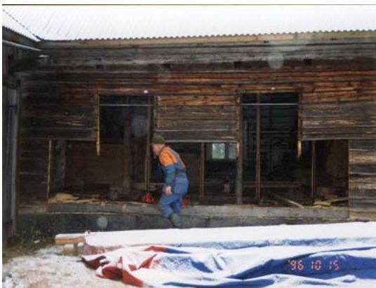
Bild 47. Lagården efter bortrivning av rötskadat timmer.
