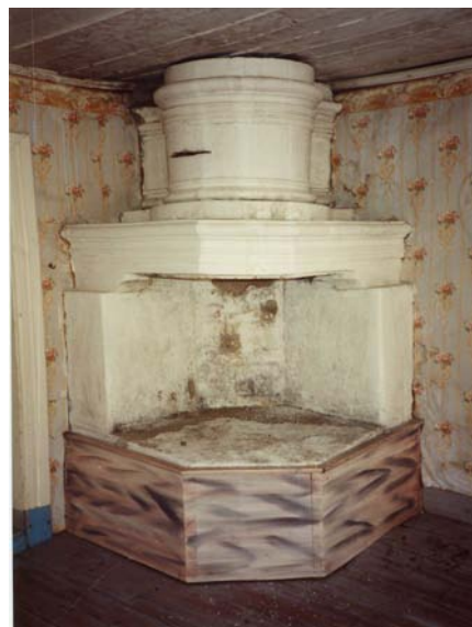
Bild 8. Spisen i enkelstugans sal före åtgärd.
