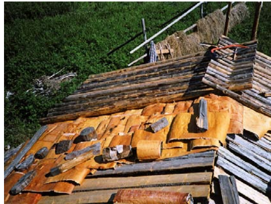
Bild 55. Färg skrapas bort från enkelstugans köksgolv. Bild 56. Nödärsladans nävertak under åtgärd.
