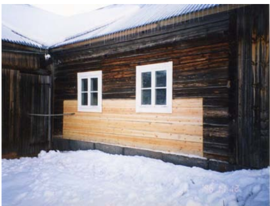
Bild 49. Ladugårdens yttervägg efter återuppbyggnad.
