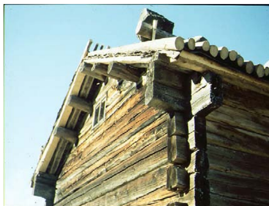
Bild 31. Närbild av kornbodens nävertak.
