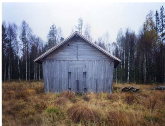
Bild 43. Norra ladan, Stenbäcksmyrän, efter åtgärd.
