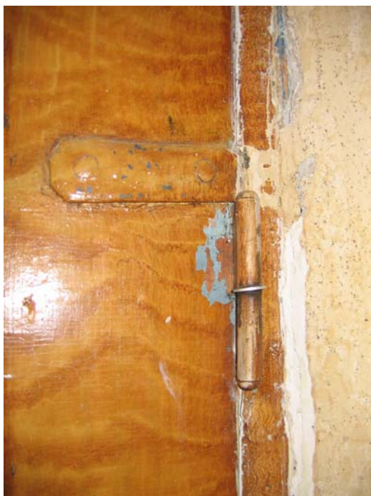
På dörren in till köket har de äldre gång-gångjärnen sågats av och ersatts med nyare.
