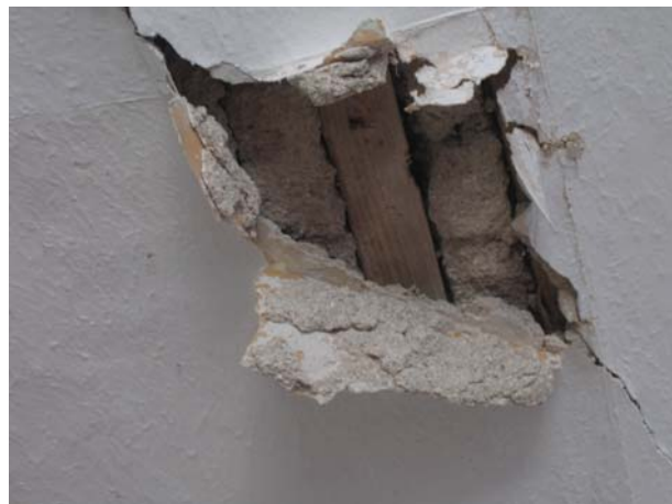
Under den limmade pappen syns takets ursprungliga kalkputs.
