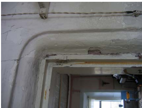
Putsfrisen bildar en mjuk övergång mellan vägg och dörr.
