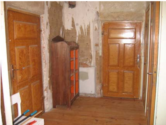
Förstugan mot salen, förstugukammaren och trapphuset.
