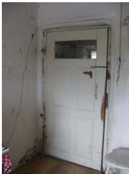
Övre fyllningen är utbytt mot glas.
