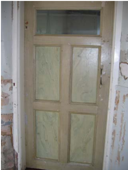
Dörrbladen mot köket är marmorerade. Den översta fyllningen är utbytt mot ett glas på dörrarna till kökskamrarna.
