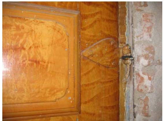
De äldre dörrarnas fyllningar är profilerade och har skurna hörn samt plattgångjärn.
