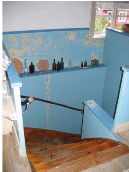
Den ursprungliga trappan ledde upp mot fönstret.
