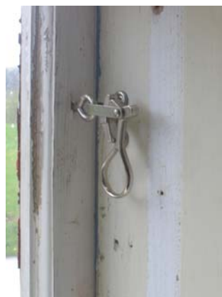
Fönsterbeslag med excenterlås av 1940-50-tals modell.
