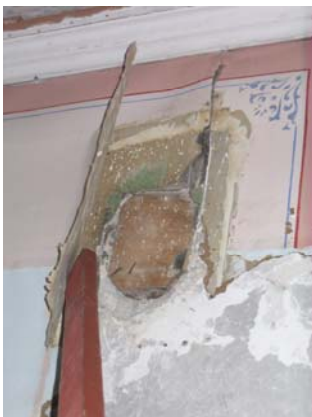
Den västra väggen har en avsågad bjälke som kan vara resterna av en storhylla.
