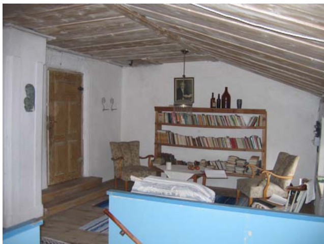
Hallens innertak följer yttertaket vinkel. Murstocken till vänster i bilden har fått en dekorativ relief i puts.
