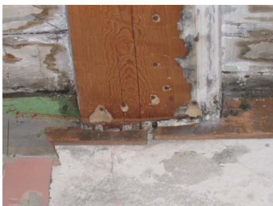
Den ursprungliga taklisten har anpassats efter efter bjälkarna i spårtaket. Till vänster syns några av de äldre målningsskikten på pappen.
