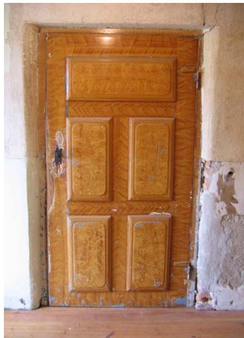
Dörren in till köket. Alla äldre dörrar har har utanpåliggande fyllningar. Under ådringen skymtar äldre målningsskikt fram.
