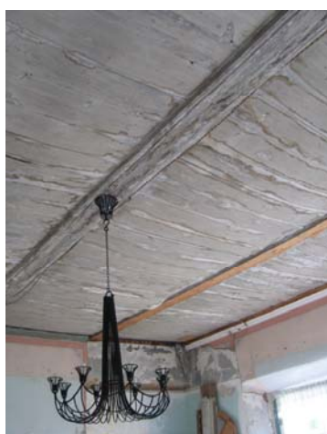
Spårtaket med de profilerade takbjälkarna, den enda intakta.
