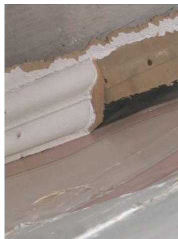
En yngre taklist sattes upp när taket pappspändes på tidigt 1900-tal.
