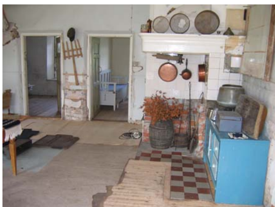
Köket med endast spiskåpan kvar av den öppna spisen. Köket moderniserades på 1940-talet. Spisen revs ut och man satte kakel och klinkers på i spishörnan. Nya golvbrädor och en linoleum-matta lades in. I bakgrunden skymtar köks-kamrarna.
