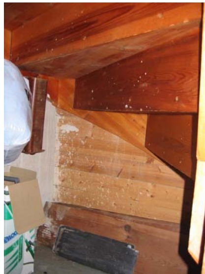
Det nya trapphuset har en stomme av panel på reglar.
