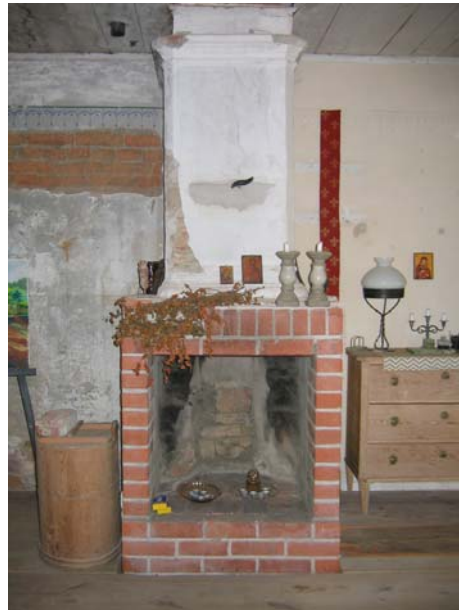
Den äldre spisen har fått ett tillägg i form av ett extra murskift framtill på 1940-talet. Till vänster om spisen har en oljepanna varit installerad. På samma väggyta finns en äldre målad dekor.
