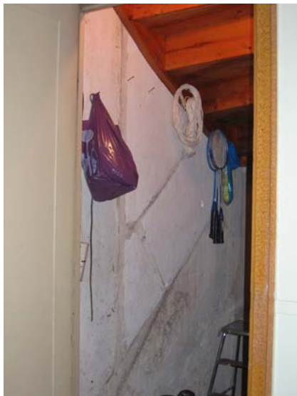
Under trappan syns märken på väggen efter den ursprungliga trappan.
