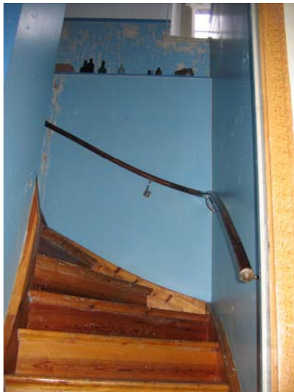
Hela trapphuset är en sentida konstruktion från 1942-43, där man ändrat på trappans riktning.
