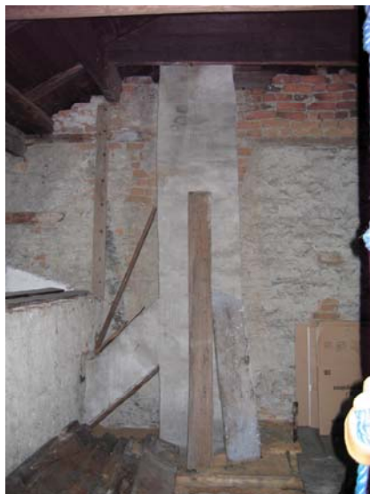
Murstocken från köket med en anslutande rökgång från inre drängkammaren.
