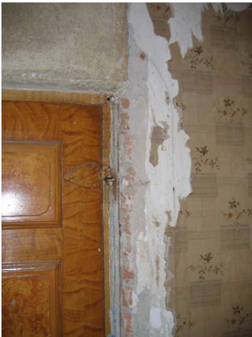
Runt dörren in till salen syns rester av den putsfris som finns bevarad i flera rum. Ursprungligen har övergången mellan dörr och vägg varit mjukt rundad, därför kan man anta att väggytorna ovanför dörrarna gjorts om då de är rakt avslutade.
