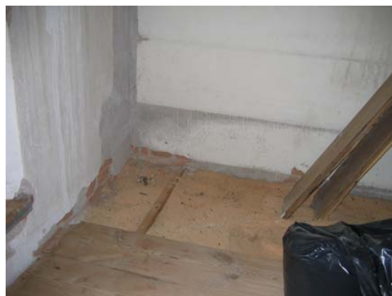
Mellanbjälklaget har fyllning av sågspån.
