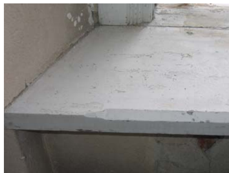
Husets alla fönsterbänkar är dekorativt avfasade i framkanten.
