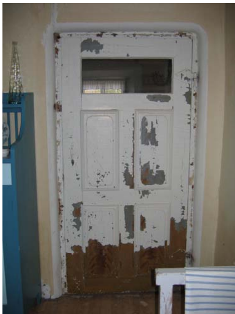
Dörrarna är delvis skrapade. Den vita färgen Tillkom på 1940-talet. Under den finns en blå kulör och en ådringsmålning.
