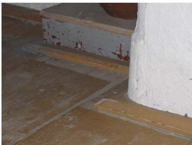
Den här "liggande" golvlisten återfinns på hela övervåningen.
