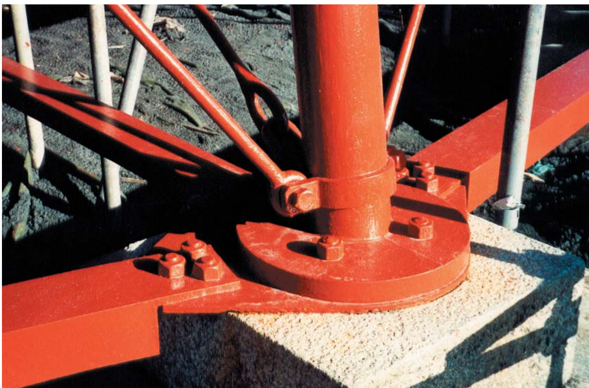
Bild 20. Närbild av fyrens fästningsanordning efter ommålning.
