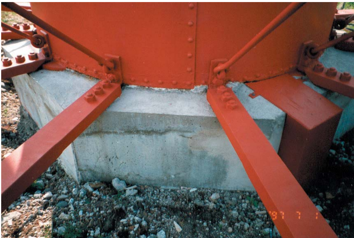
Bild 21. Närbild av fyrens fundament efter åtgärd.
