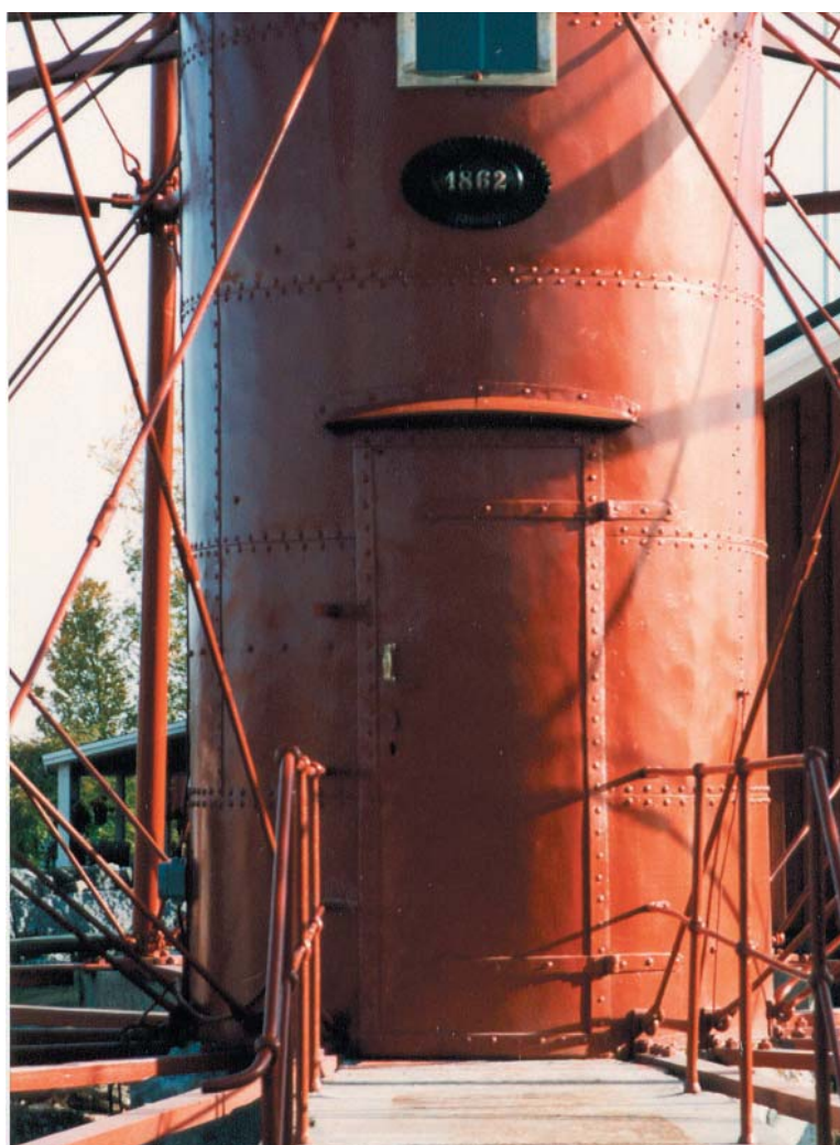
Ingången till fyren efter färdigt arbete.
