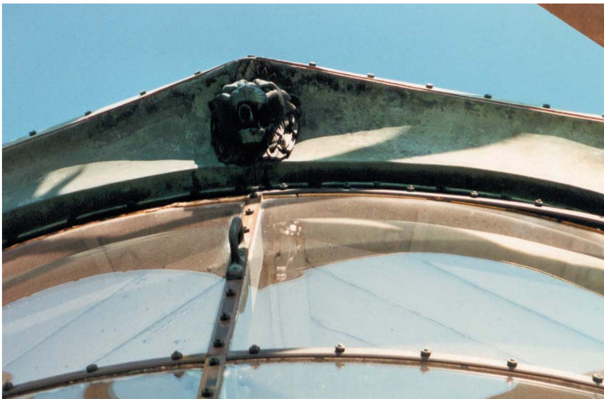
Bild 9. Närbild av lanterninens fönster och vattenutkastare före åtgärd.
