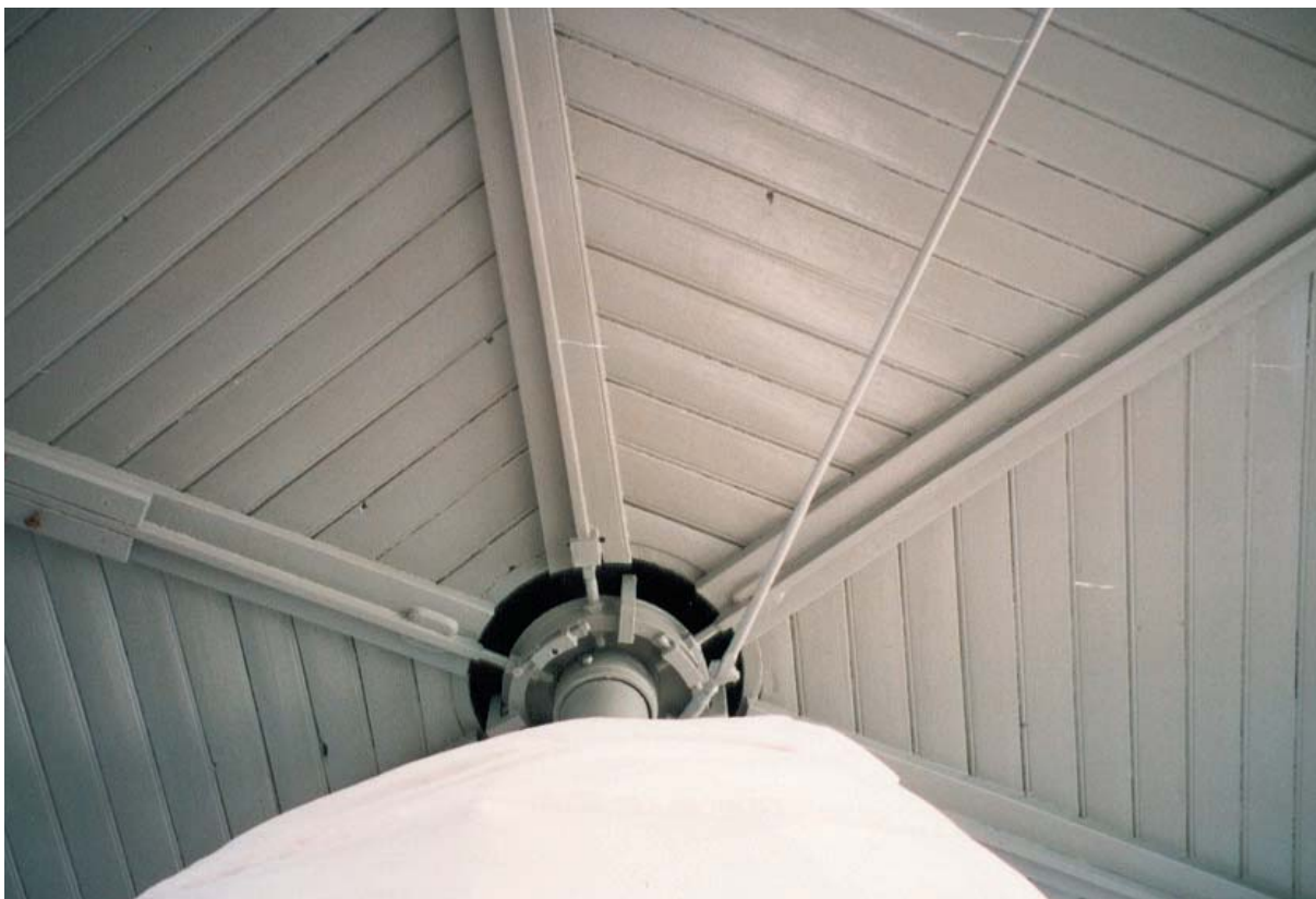
Bild 45. Närbild av lanterninens innertak efter ommålning.
