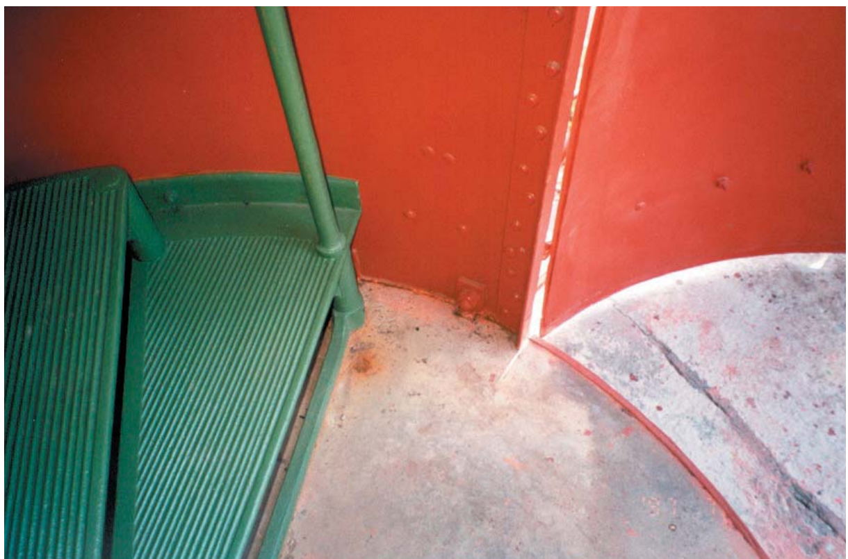
Bild 24. Närbild av trappan och golvet efter åtgärd.
