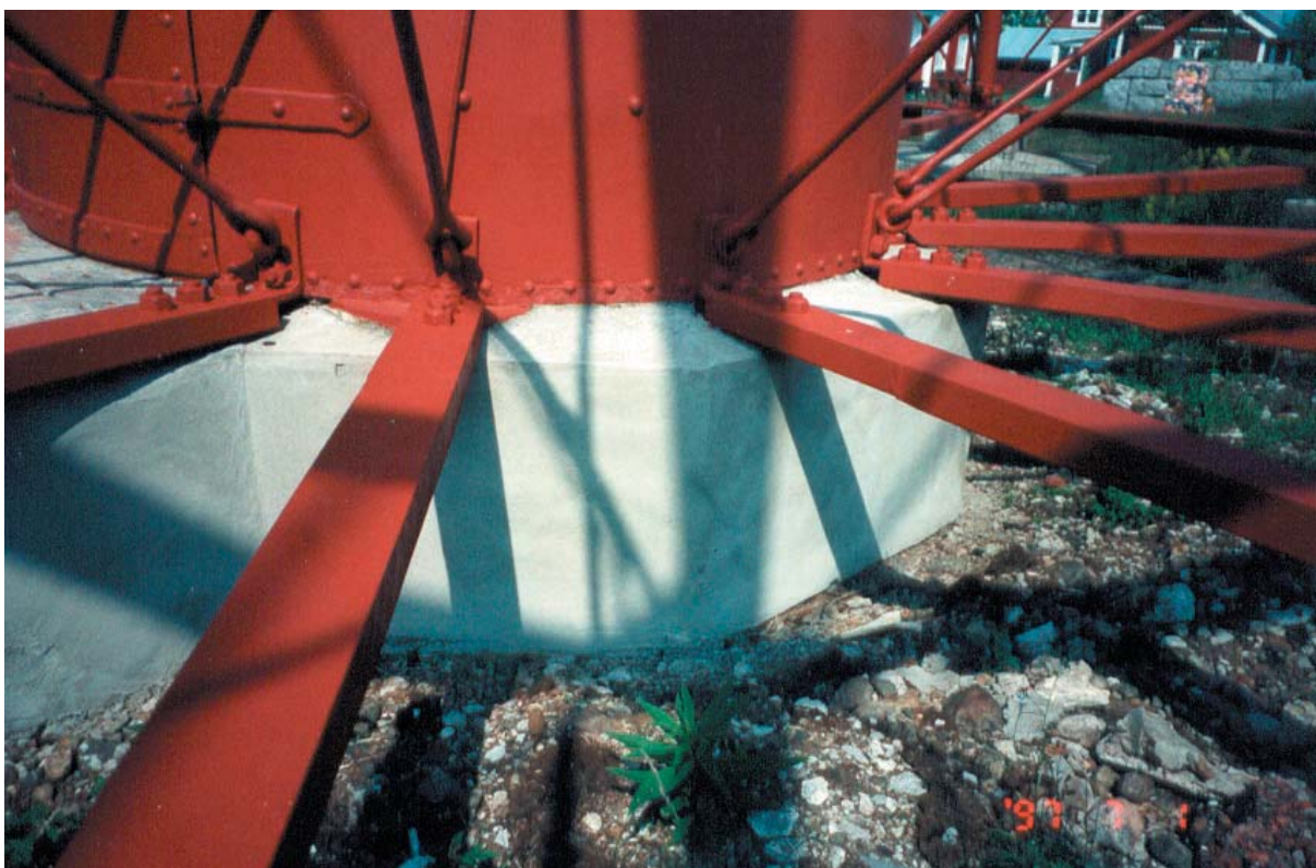
Bild 22. Närbild av fyrens fundament efter åtgärd.
