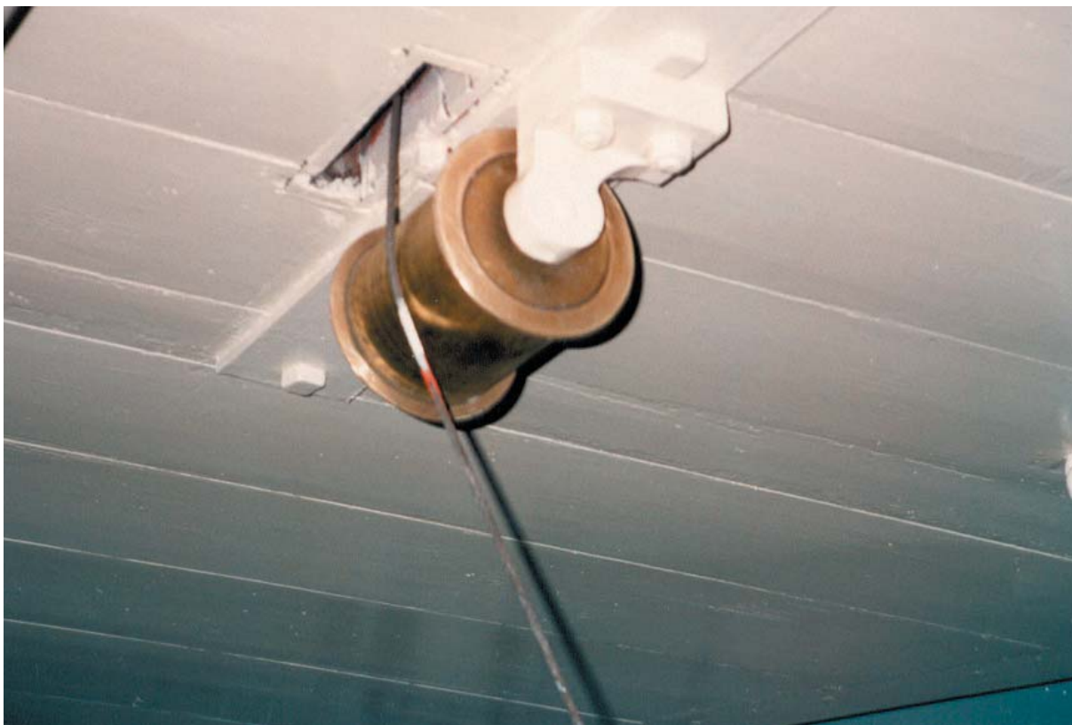
Bild 36. Närbild av mässingsdetalj i fyrhuset efter polering.
