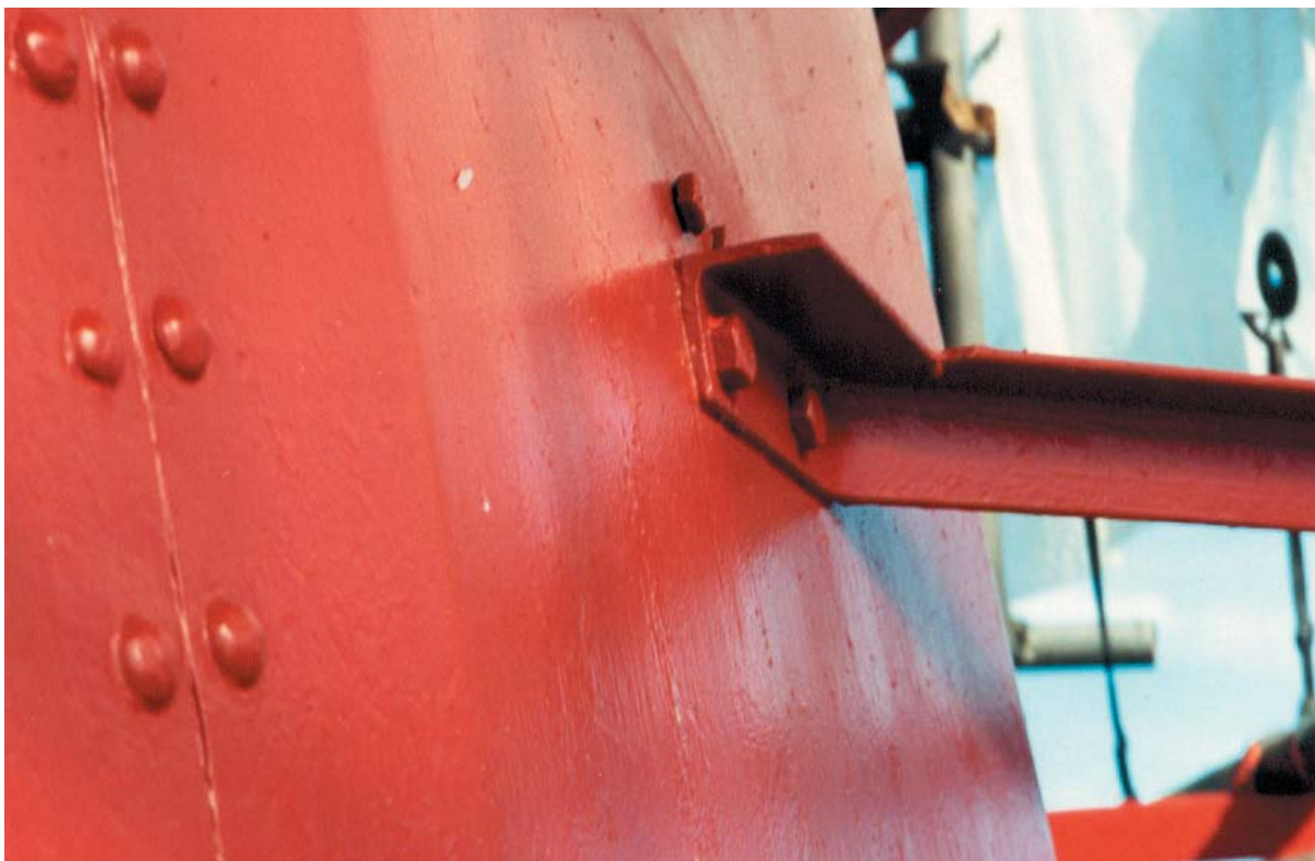
Bild 31. Närbild av fyrhuset efter ommålning.
