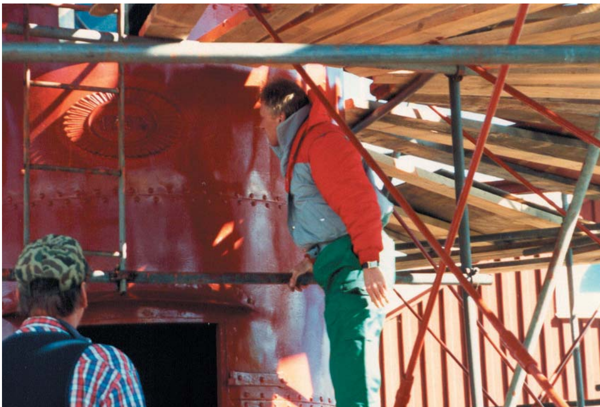
Bild 16. Fyren under slutbesiktningen.
