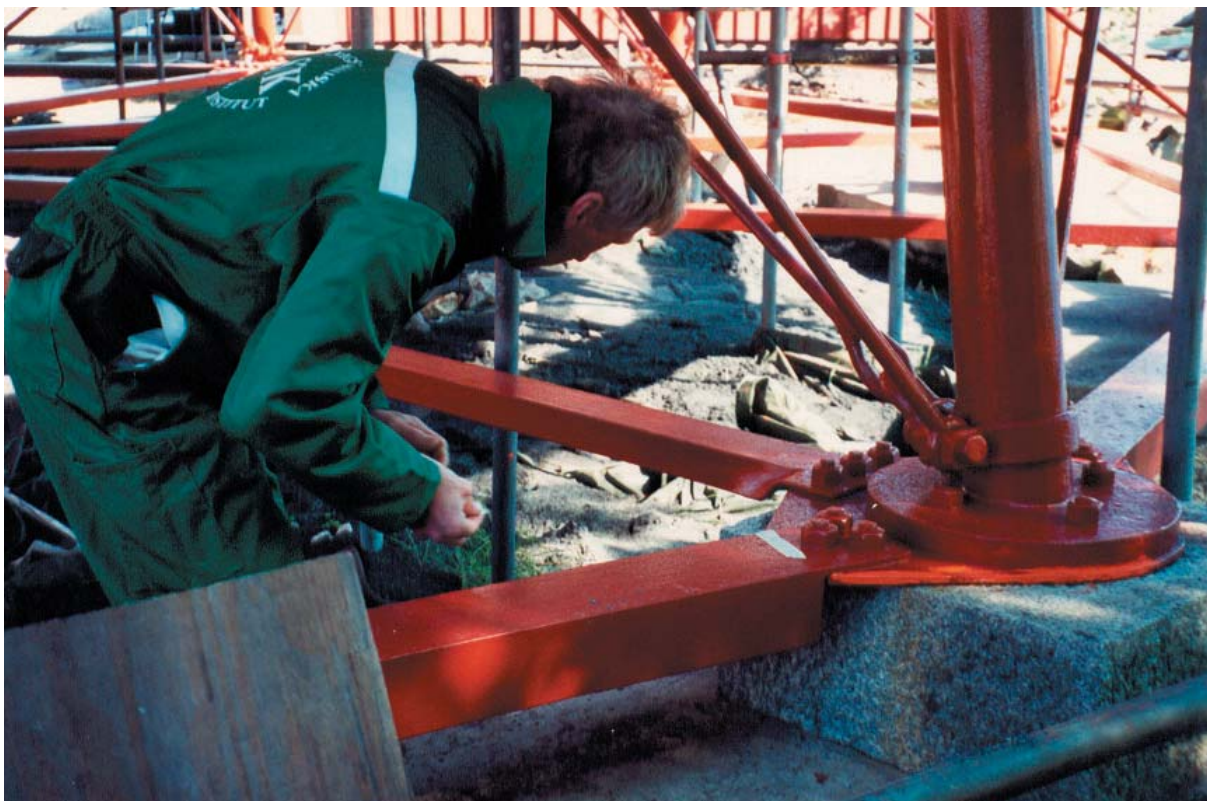
Bild 19. Närbild av fyrens fästningsanordning efter ommålning.
