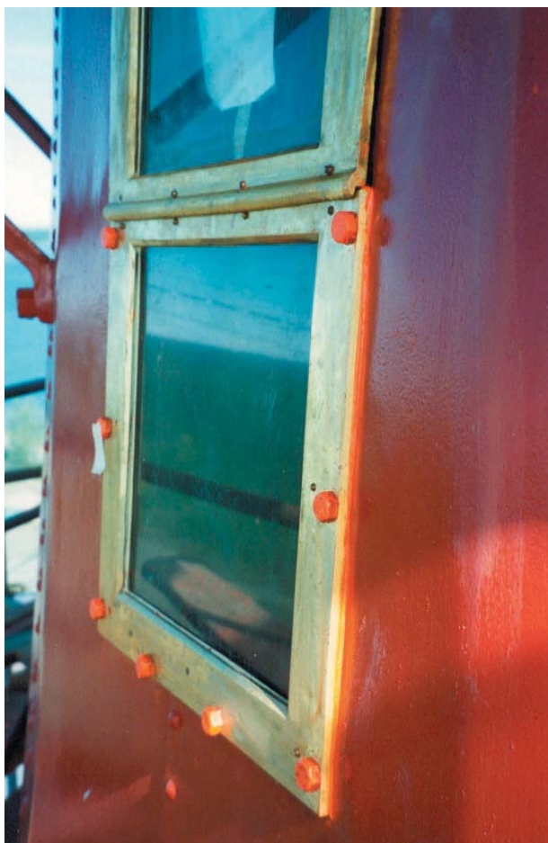
Bild 29. Närbild av fönster i fyrhuset efter åtgärd.
