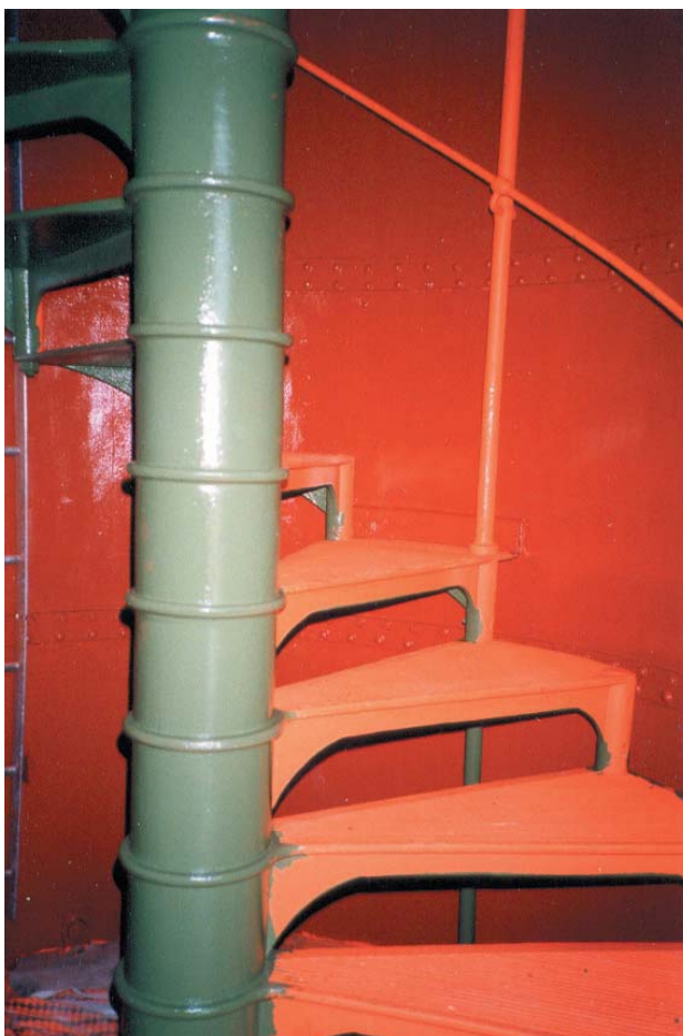
Bild 6. Trappan upp till lanterninen under blästring.
