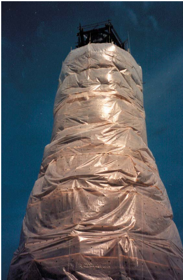
Bild 1. Fyren under blästringsarbetet.
