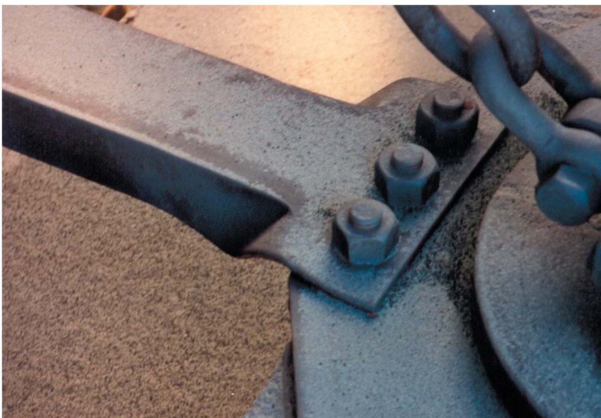
Bild 4. Närbild av fyrens fästningsanordning efter blästring.
