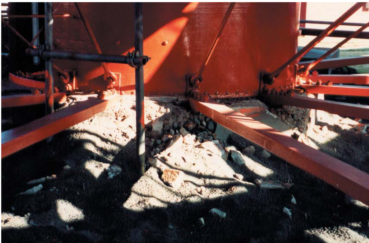
Bild 17. Närbild av fyrens fundament under åtgärd.
