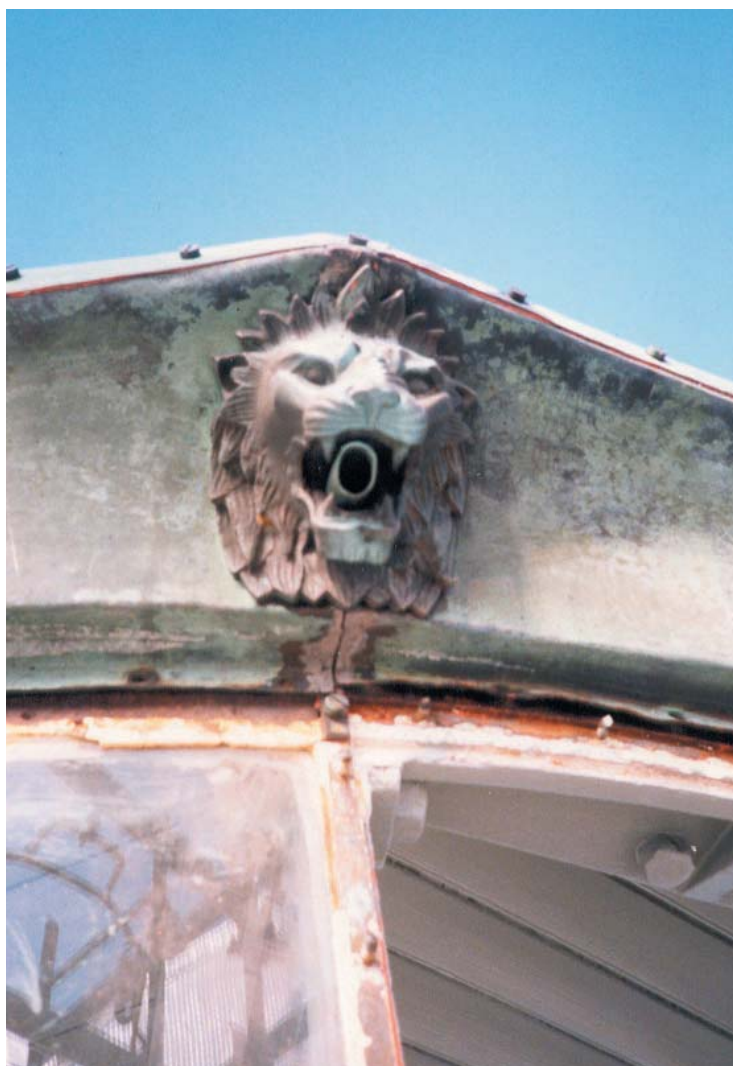
Närbild av vattenutkastare på lanterninen.
