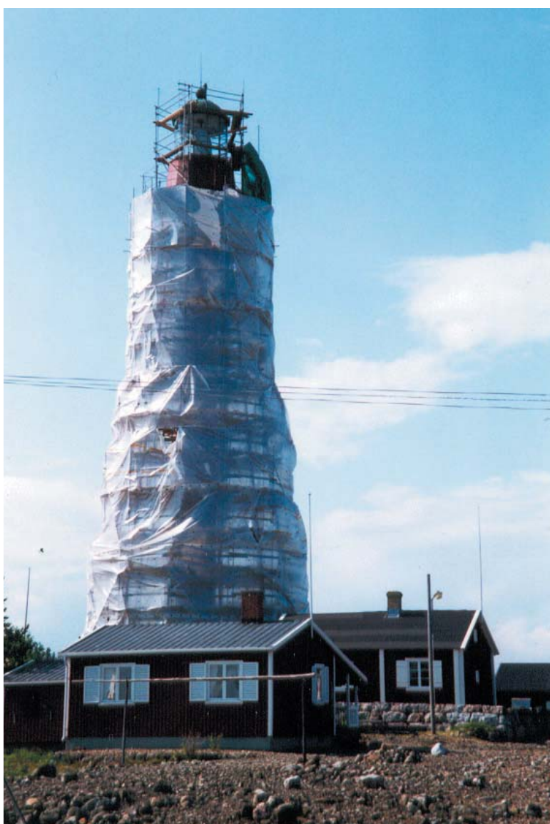
Fyren under arbete.
