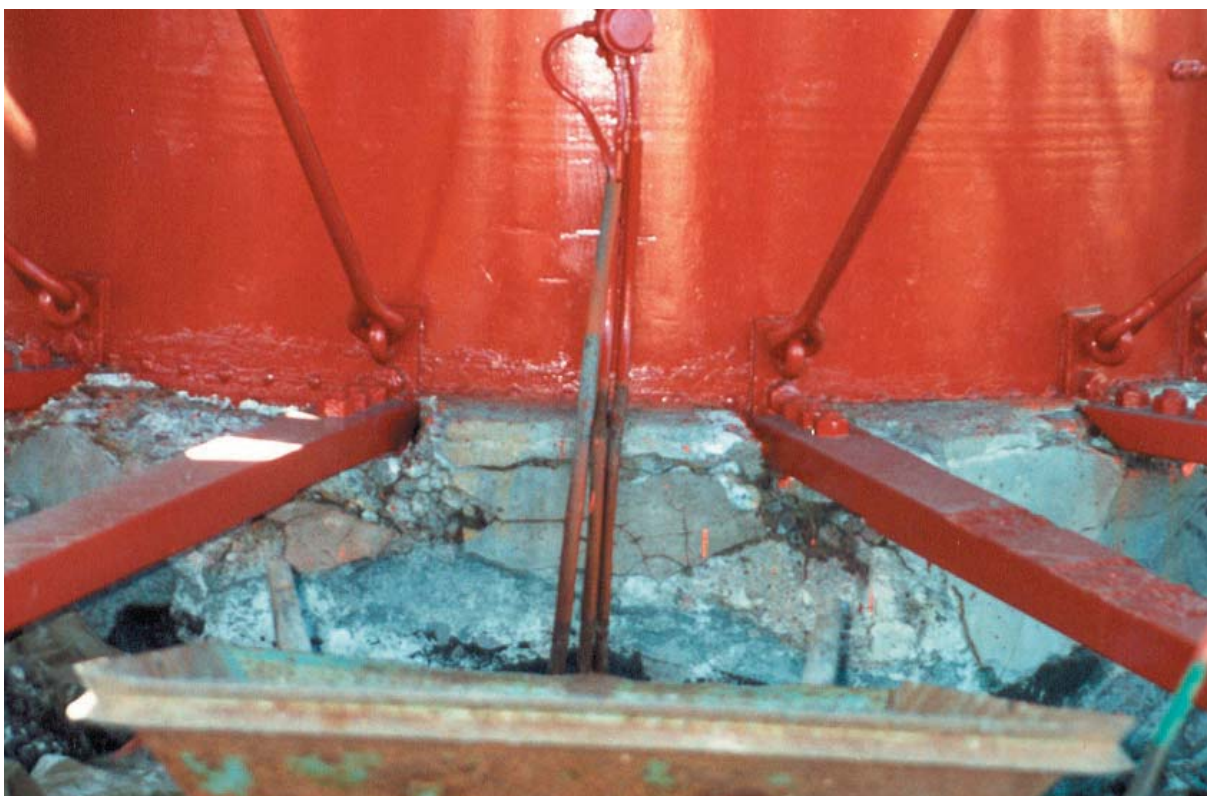
Bild 18. Närbild av fyrens fundament under åtgärd.
