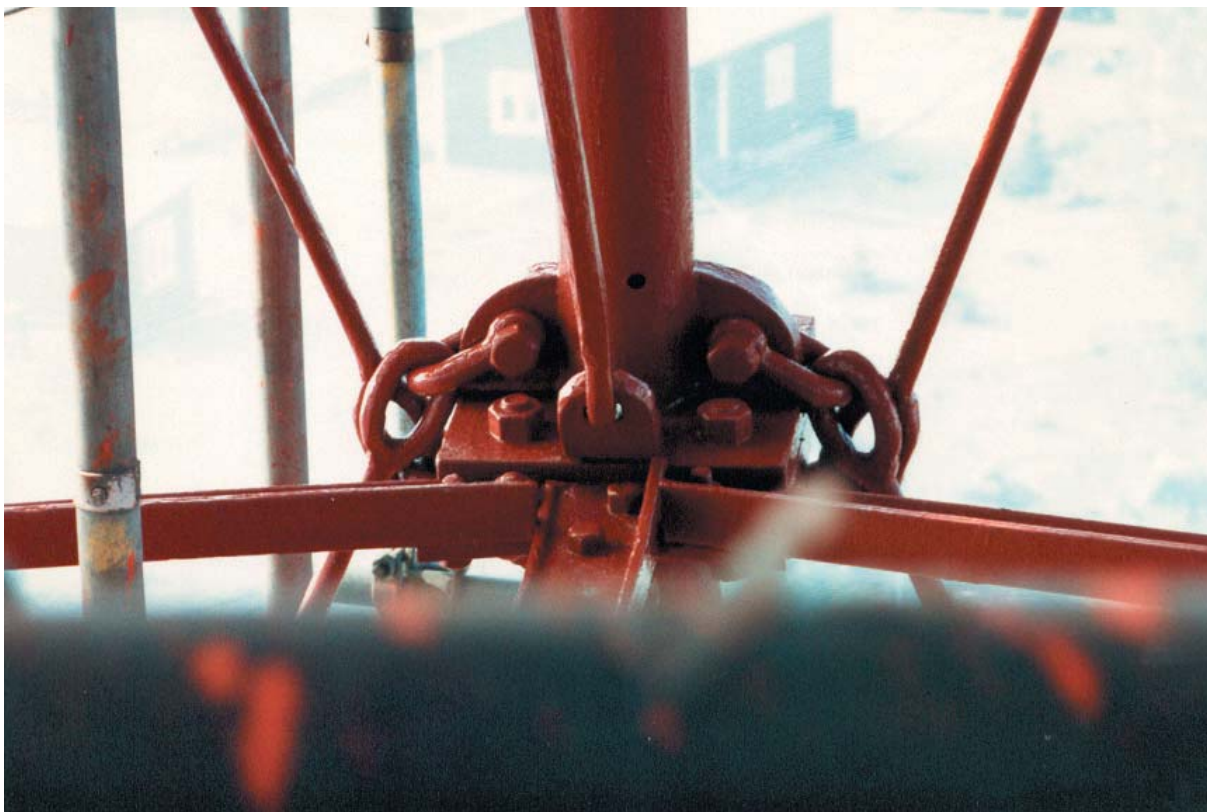
Bild 30. Närbild av lanterninens fästningsanordning efter ommålning.
