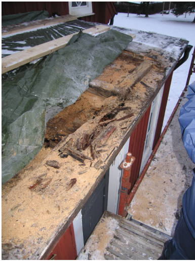
Bild 13. Taket efter att pappen avlägsnats.
