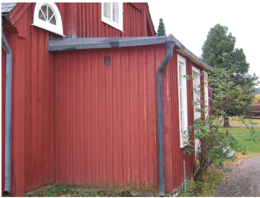
Bild 15. Taket efter åtgärd.
