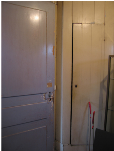
Bild 7. Köksdörren före åtgärd.
