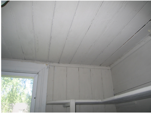
Bild 20. Tak och väggar målade med limfärg.
