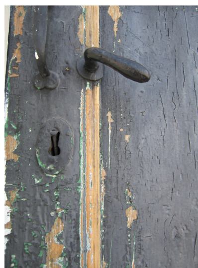
Bild 12. Närbild av färglager på enkeldörren.
