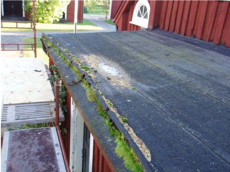
Bild 1. Taket på utbyggnaden före åtgärd.
