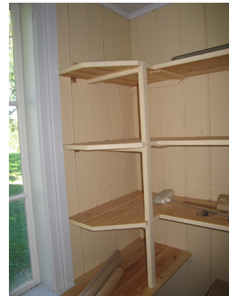
Bild 19. Hyllor efter åtgärd.
