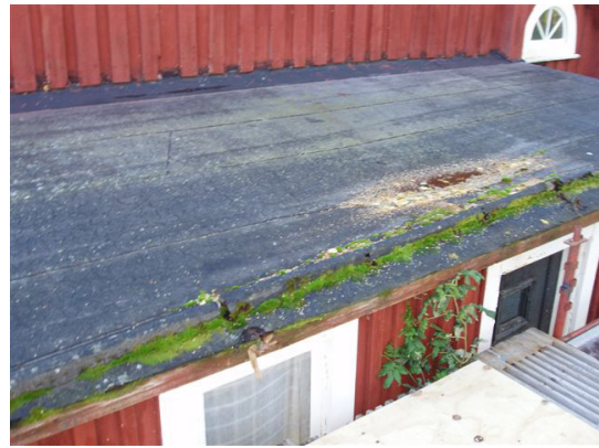
Bild 4. Yttertakets yta på förstugan före åtgärd.
