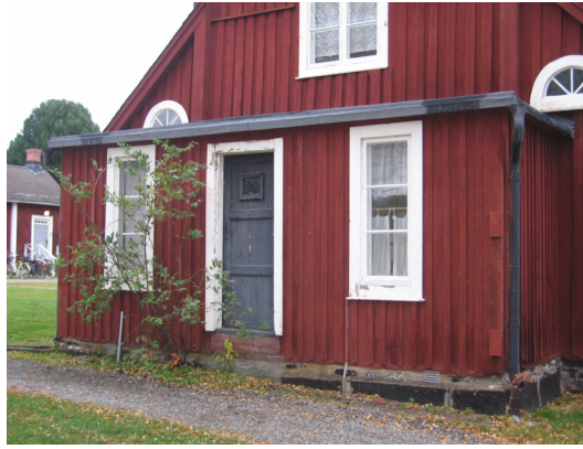
Bild 14. Taket efter åtgärd.
