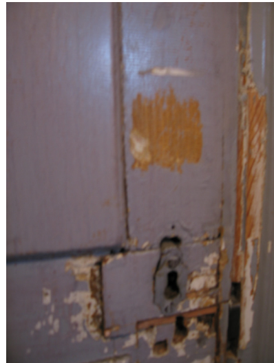
Bild 8. Närbild av köksdörren före åtgärd.
