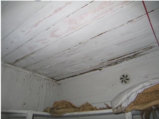
Bild 5. Innertaket i södra utrymmet före åtgärd.
