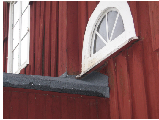
Bild 16. Detalj av taket efter åtgärd.
