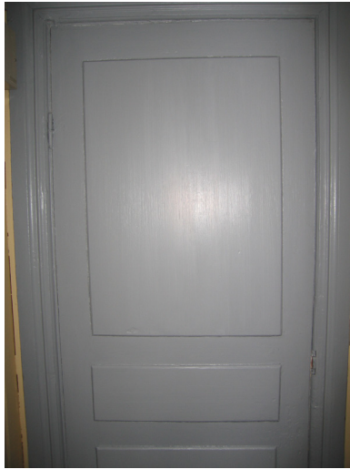
Bild 22. Köksdörren efter åtgärd.
