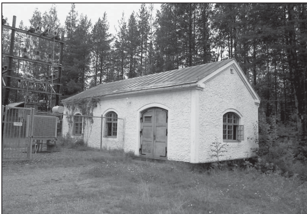
Nedre Fäbodäckens kraftstation, anlagd 1933. Foto Lage Johansson.
