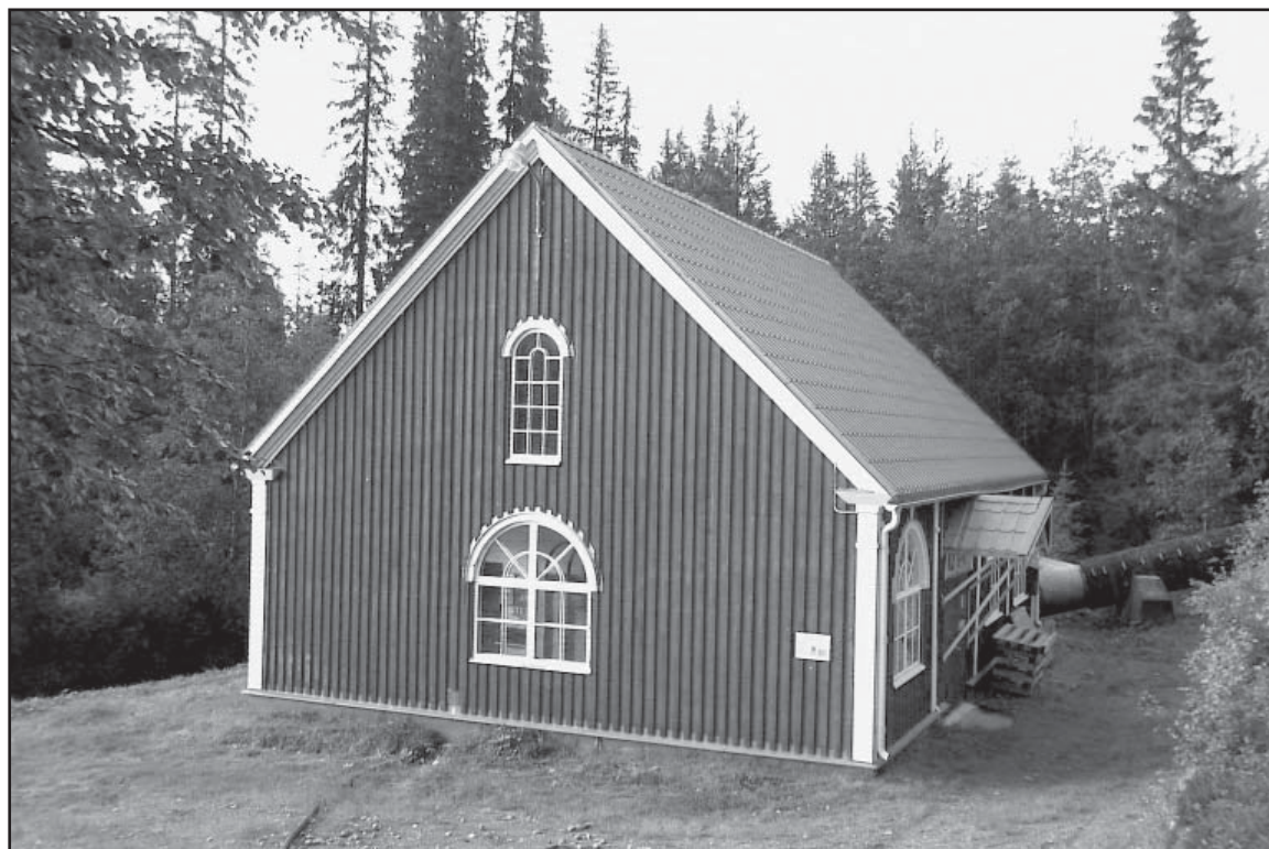
Dalasjö kraftstation. Foto Lage Johansson.
