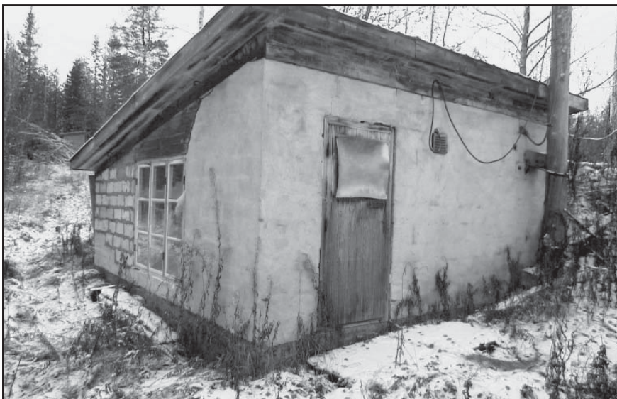
Forslidens kraftstation, Forsliden, Burträsk socken. Foto Lage Johansson.
