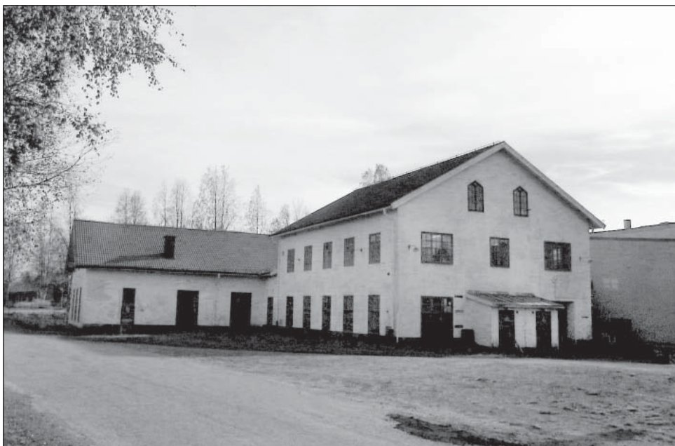
F d verkstad tillhörig Robertsfors bruk. Idag del av Norrlandsgjuteriet. Foto Lage Jhansson.
