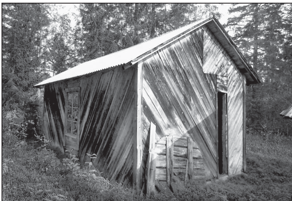
Långron. Maskinhus till såg med bevarad ångmaskin. . Foto Lage Johansson.
