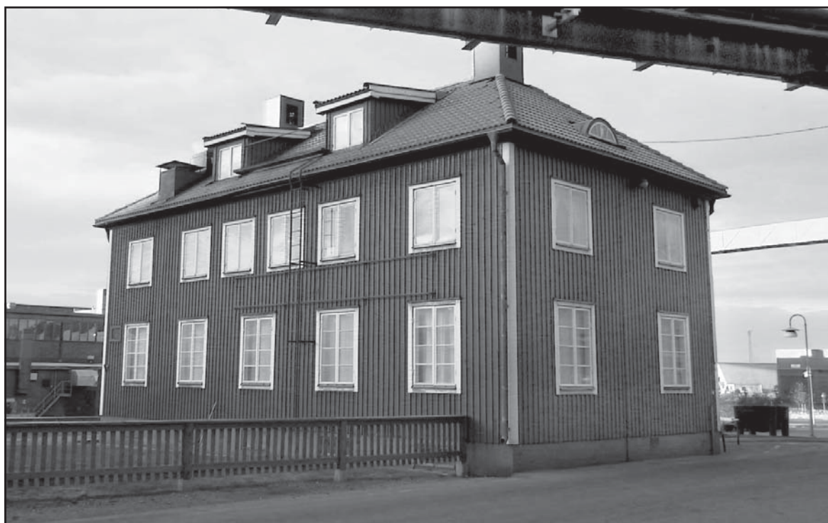
Museum Rönnskär har byggts upp i det gamla kontoret på industriområdet. Foto Lage Johansson.
