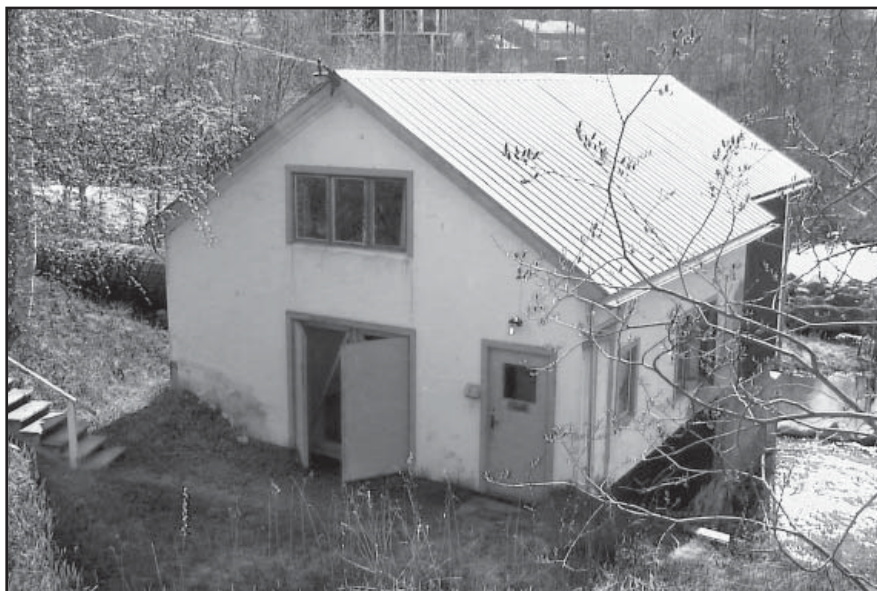
Åmsele kraftstation. Foto Lage Johansson.
