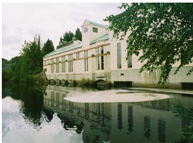
Bild 2. Kraftstationen sedd från vattnet. Foto: Skellefteå kommun.
