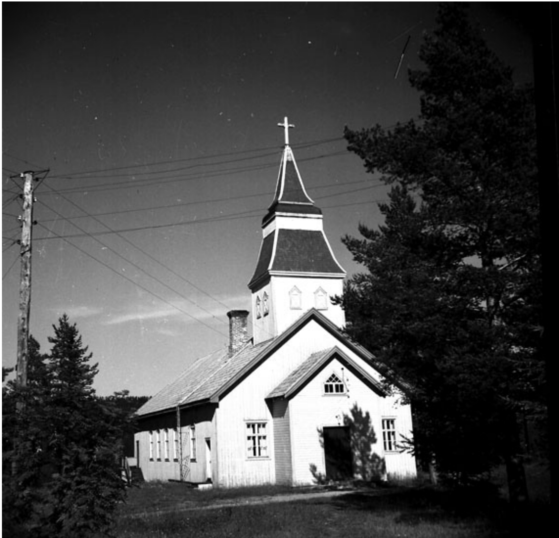
Bild A 00305 Bygdsiljums kyrka före uppförandet av det fristående tornet.
