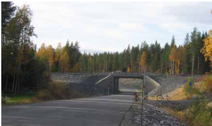
Nya E4 med undergång.
