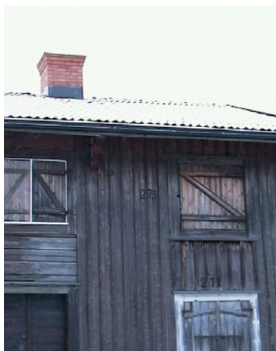
Bild 5. Närbild på skorsten efter åtgärd.
