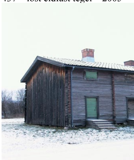
Bild 4. Skorsten efter åtgärd.
