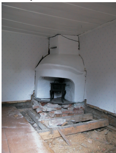
Bild 6. Kamamre 98 under åtgärd.
