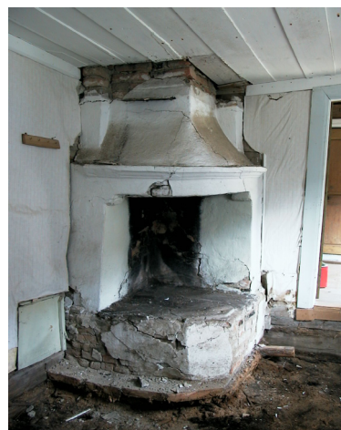
Bild 9. Kammare 241 under åtgärd.
