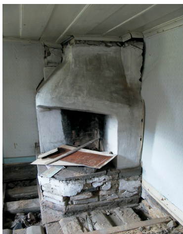
Bild 8. Kammare 230 under åtgärd.
