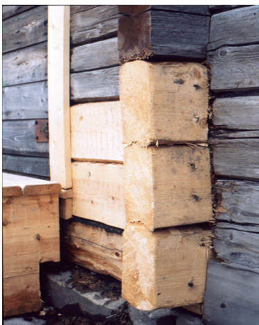
Bild 10. Närbild av nya knutskallar.
