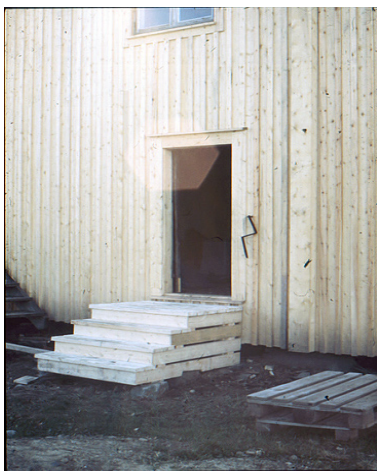
Bild 9. Nyuppsatt locklistpanel.
