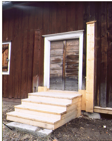
Bild 10. Närbild av nya knutskallar.
