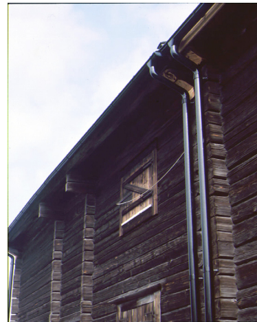
Bild 12. Nya rännor och rör.
